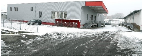
Einfahrt vom Wollersheimer Weg (mit Vorder- und Seitenansicht des Gebäudes)
